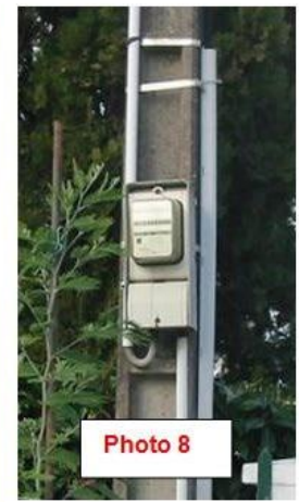
Compteur extérieur apparent
